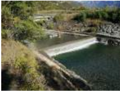
Vista delle due vasche colme di materiale subito a valle del secondo ponte su tre - Foto stazione forestale di Verres
