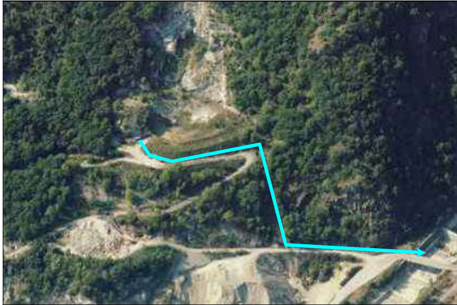
Scarico acque superficiali
