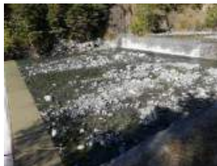
Vista vasche tra il secondo ponte su tre ed il ponte superiore – proseguendo in direzione monte, il materiale solido depositato aumenta di granulometria – Foto stazione forestale di Verres
