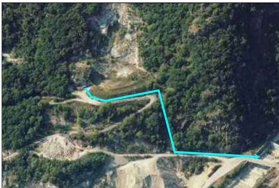
Scarico acque superficiali
