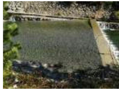
Vista delle due vasche colme di materiale subito a valle del secondo ponte su tre - Foto stazione forestale di Verres
