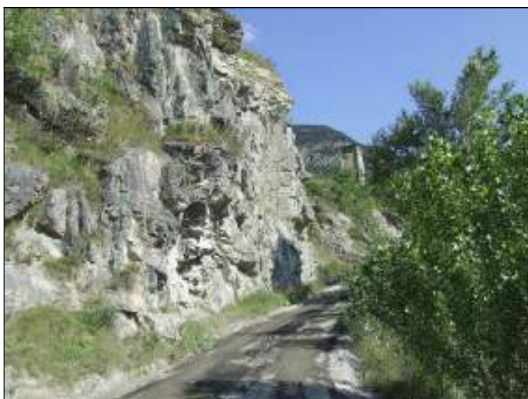
Falesia presente a ridosso dell'impianto
