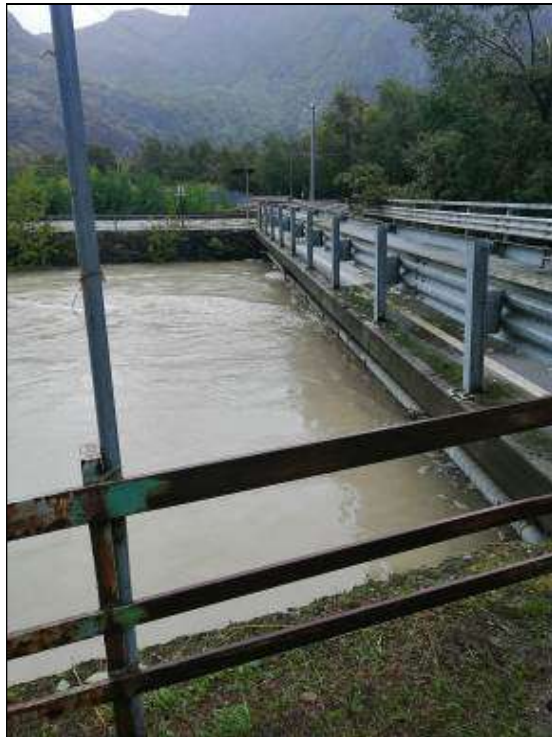
Ponte sul torrente Chalamy
