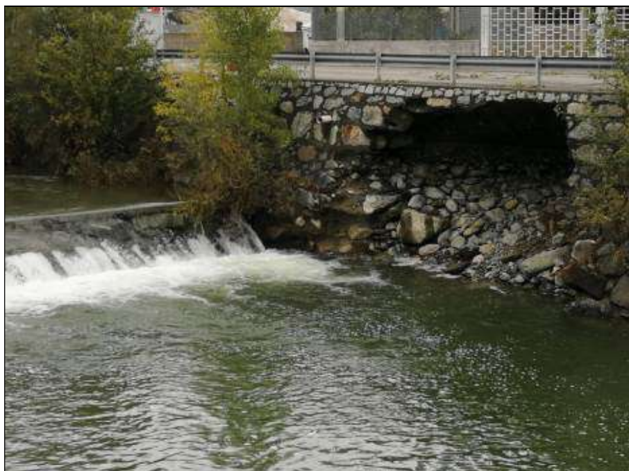
Sponda sinistra del torrente Chalamy
